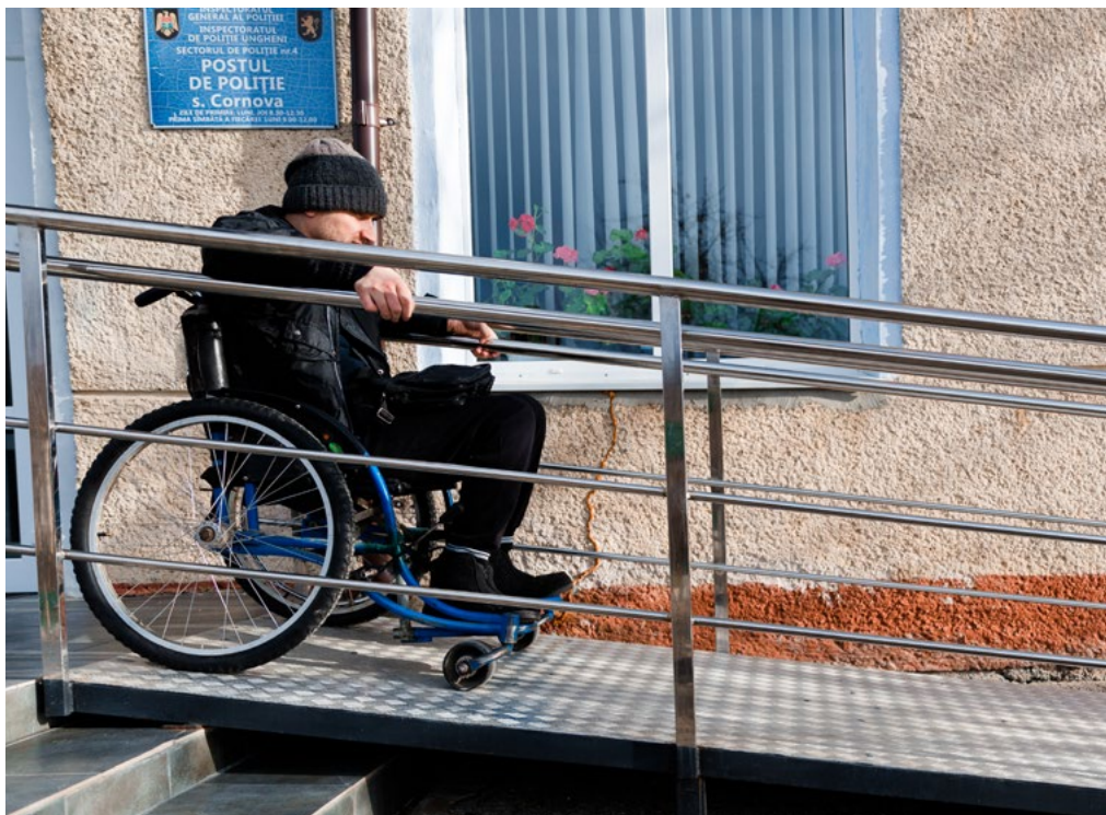
Rampă de acces instalată la clădirea Primăriei Cornova, subregiunea Cula, raionul Ungheni.
